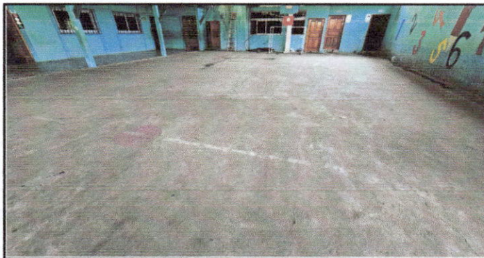
Foto 5: pintura interior y exterior
