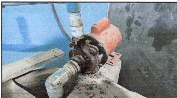
Foto 4: sustitucion de Bomba de agua
