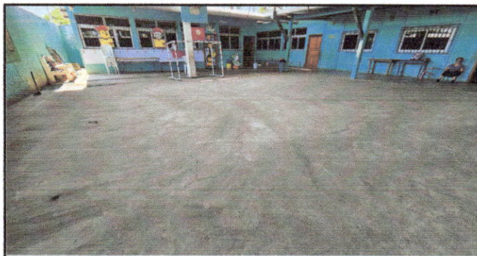
Foto 6: pintura interior y exterior
