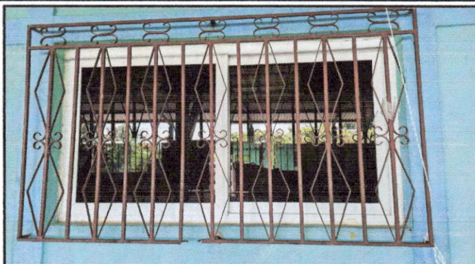
Foto 2: sustitucion de balcones
