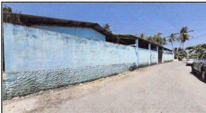
Foto 3: pintura interior y exterior de la escuela
